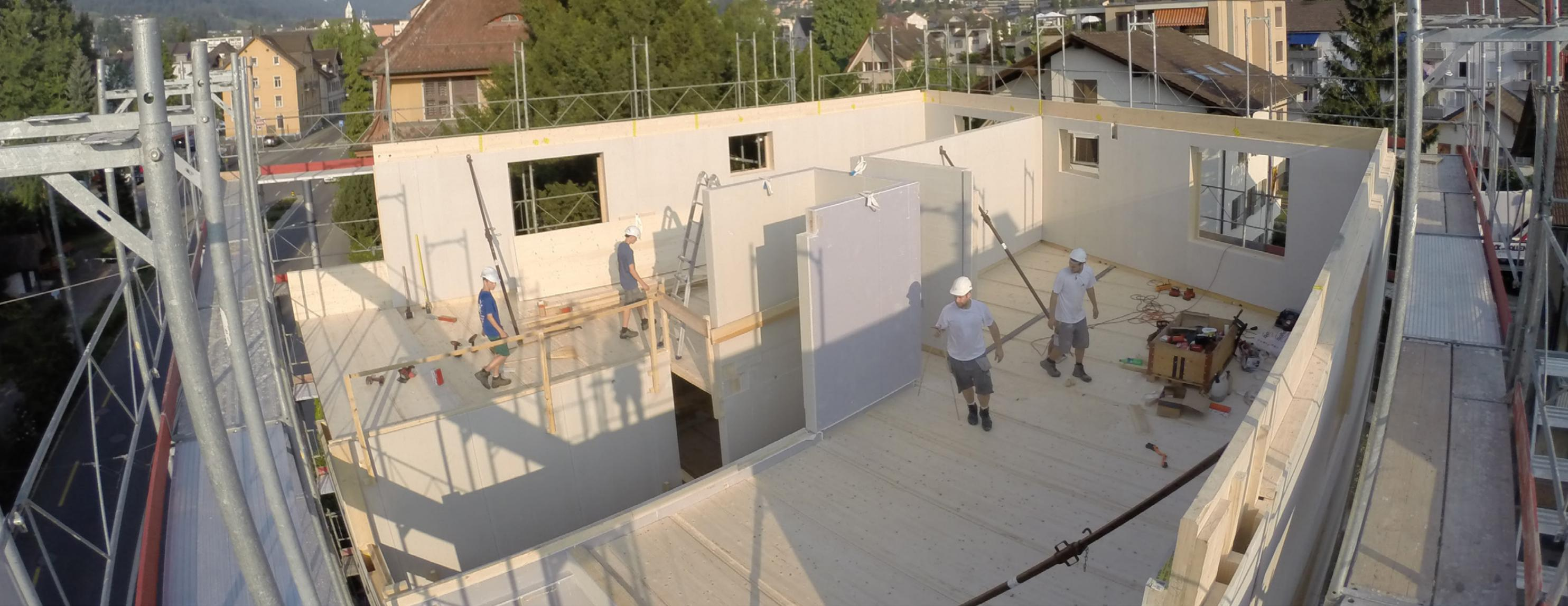
**Vor diesem Hintergrund entsteht derzeit in Kriens im Kanton Luzern ein Mehrfamilienhaus, das in technisch konstruktiver Hinsicht eine Premiere darstellt: Der Holzbau, der entsprechend den neuen Brandschutzrichtlinien als Gebäude mittlerer Höhe gilt, ist der erste Viergeschossiger, der mit Zellulosedämmung im Wandhohlraum geplant wurde und damit dem weit verbreiteten Vorbehalt entgegentritt, dass Zellulosedämmungen ab einer bestimmten Höhe nicht mehr einsetzbar seien.**
