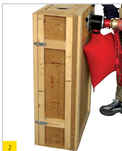
Verdichtetes Einblasen mit entlüfteter Drehdüse
