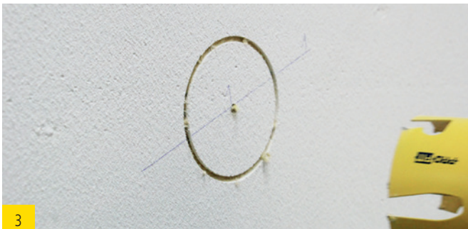
Putzschicht vorgebohrt
