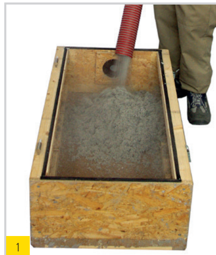
1 Offenes Aufblasen mit Schlauch
