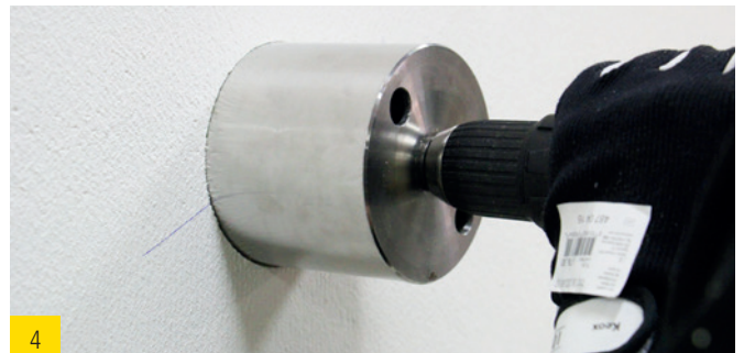
mit Lochsäge (ED) Öffnung herstellen
