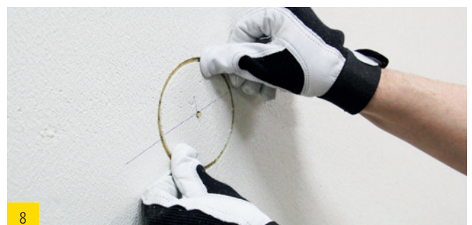
... und oberflächenbündig eindrücken
