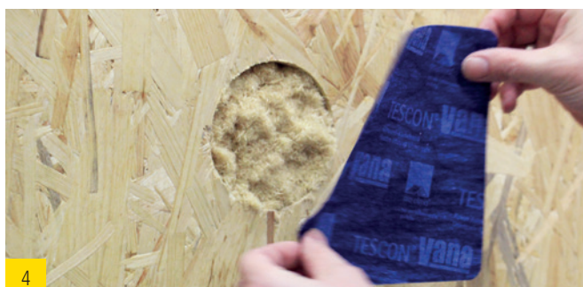
4 Öffnung mit Klebepatch verschließen
