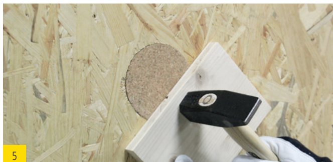
5 Bei Brandschutzanforderungen mit Korkstopfen verschließen
