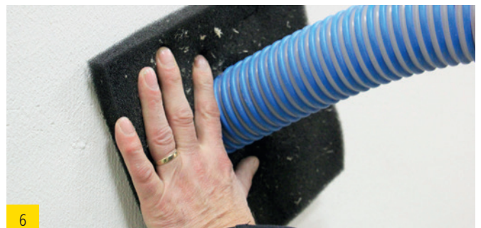
Einblasdämmung einbringen
