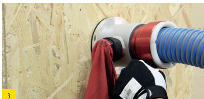
3 Einblasdämmung einbringen
