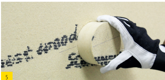
5 Bohrstopfen einsetzen ...
