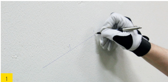
Einblasöffnung anzeichnen und nummerieren
