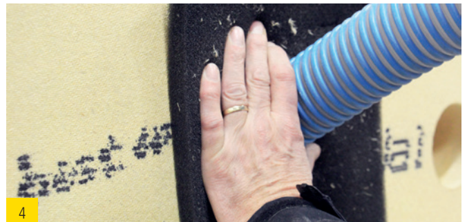
4 Einblasdämmung einbringen
