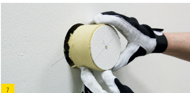
Bohrstopfen einsetzen ...
