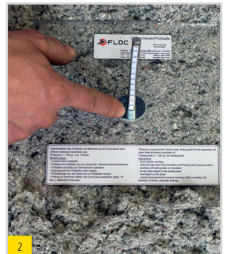
2 Dickenmessung einer offen aufgeblasenen Dämmung mit dem Dickenmesser
